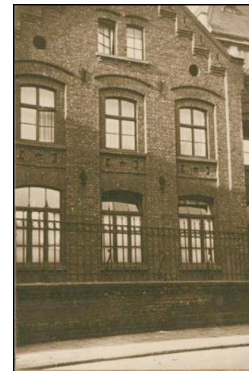
Haus an der Michaelstraße 57, ehemaliges Schulhaus der jüdischen Gemeinde
