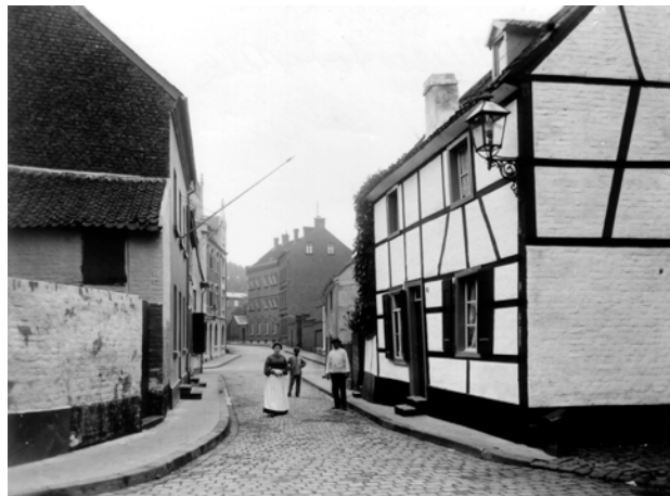
Der Hamtorwall, Anfang des 20. Jahrhunderts
