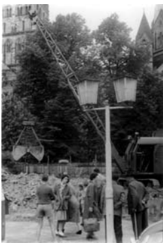
Trümmerräumung am Markt, um 1950 (Stadtarchiv Neuss, E.02.01)
