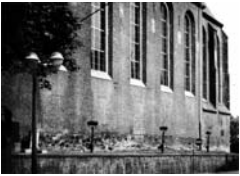
Die aus den Museumstrümmern stammenden Tuffsteingewände der Fensteröffnungen des sanierten Zeughauses (Stadtarchiv Neuss, E.02.02.06)
