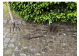
Der von einer Wurzel, Schlamm und Blättern befreite Abfluss im Innenhof des Stadtarchivs (Stadtarchiv Neuss)
