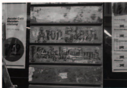
Noch in den 1990er Jahren fanden sich letzte Spuren der Familie Stein auf der Fassade des Hauses Büttger Str. 18.
